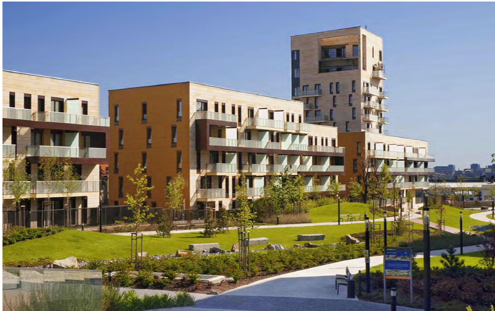
Residenční Park, Baarova ulice, Praha
