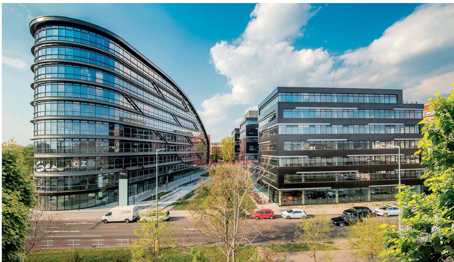
1 Administrativní soubor ArtGen: celkový pohled od jihu , vlevo budova ART, vpravo GEN.
